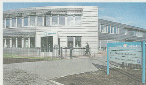
Neue Heimat von Scheuten Solar: die Produktionsstätte am Schalker Markt.
